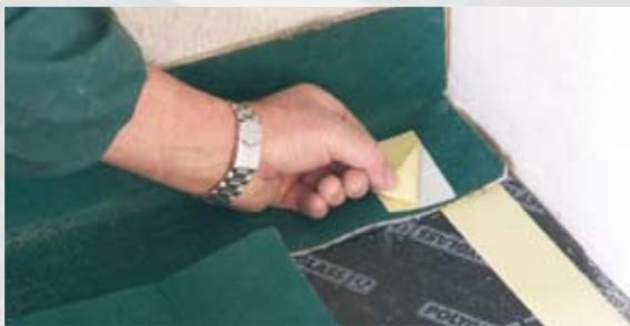
**d)** Liberare la parte superiore adesiva del nastro bi-adesivo ed incollare la striscia di SONIC BAND sul SONIC PANEL in maniera precisa e continua.
