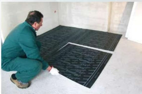
**b)** Incollare sui pannelli di SONIC PANEL, lungo tutto il perimetro, il nastro bi-adesivo.
