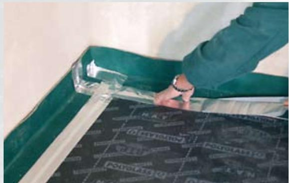
i) Al termine del lavoro, il nastro argentato SONIC TAPE, dovrà essere visibile su tutte le sovrapposizioni e giunzioni del SONIC PANEL e del SONIC BAND. Per nessun motivo dovranno essere presenti punti passanti di contatto con il sottofondo; sarà così formata una sorta di "vasca" idonea a ricevere e contenere il composto fluido tipico dei massetti autolivellanti.
