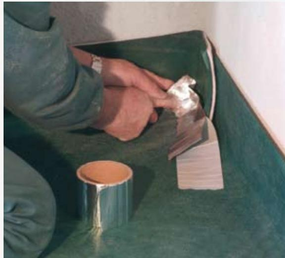
i) Al termine del lavoro, il nastro argentato SONIC TAPE dovrà essere visibile su tutte le sovrapposizioni e giunzioni del SONIC ROLL e non dovranno essere presenti punti passanti di contatto con il sottofondo; sarà così formata una sorta di "vasca" idonea a ricevere e contenere il composto fluido tipico dei massetti autolivellanti.
