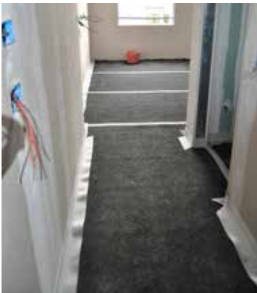
▲ Posa materassino Damproll presso cantiere alloggi dell' UNIVERSITÀ DI LECCO
