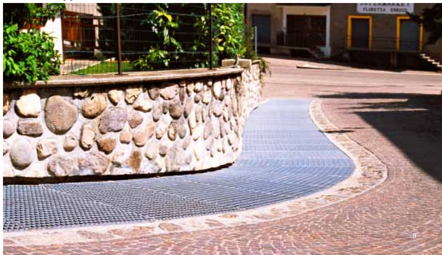
Canale grigliato della Gridiron. Incanalamento del Rio Dervichel a Trento
