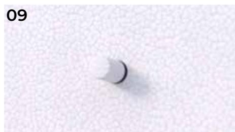
TERMINATA LA FASE DI FISSAGGIO (07) SINO A COMPLETA ESPANSIONE DEL FUSTO (08), ESTRARRE LA BARRA DI REGOLAZIONE E CHIUDERE IL FORO CON L'APPOSITO TAPPO DI CHIUSURA (09).
